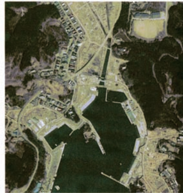
（被災後；平成23年4月1日撮影）
