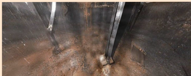
2号機原子炉格納容器内部調査におけるペDESTAL底部の様子(2018年1月)(一部加工)/ 映像提供:国際廃炉研究開発機構(IRID)/映像処理:東京電力ホールディングス株式会社
